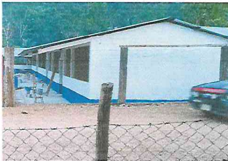
Foto 3: Acabado de pintura exterior en el modulo No. 1
