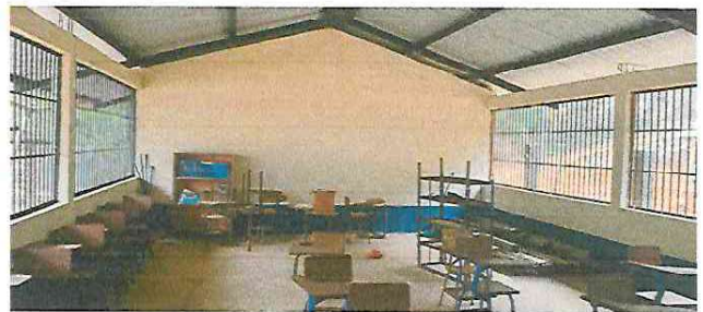
Foto 4: Pintura interior en el modulo No. 2
