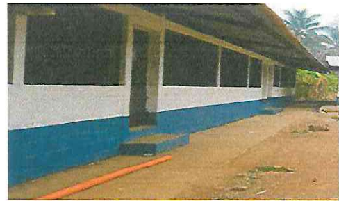
Foto 2: Obra concluida de pintura exterior e interior del modulo No. 2
